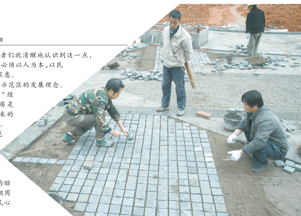
安置楼的每一处都经过了施工人员的用心施工。
