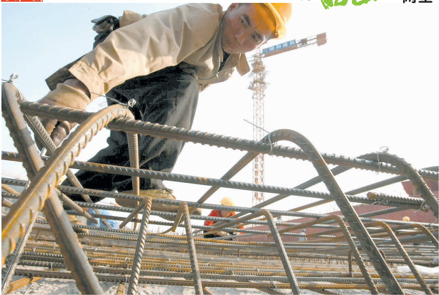
施工如火如荼的昭山两型产业发展中心工地上,一名工人一丝不苟的紧固一根根基脚钢筋。
