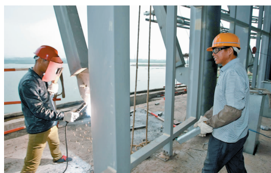
认真焊接好每一根钢架构件。
