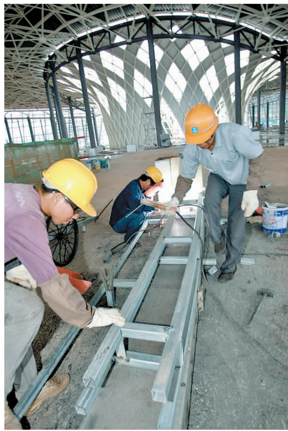
在仰天湖展馆,技术人员在细心施工。
