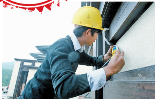
在昭山晴岚项目现场,师傅在冒雨装修室外工程。
