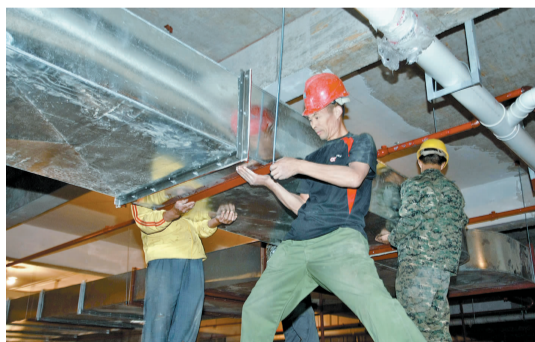
在“两型”产业发展中心项目现场,工人正安装配套设施。
