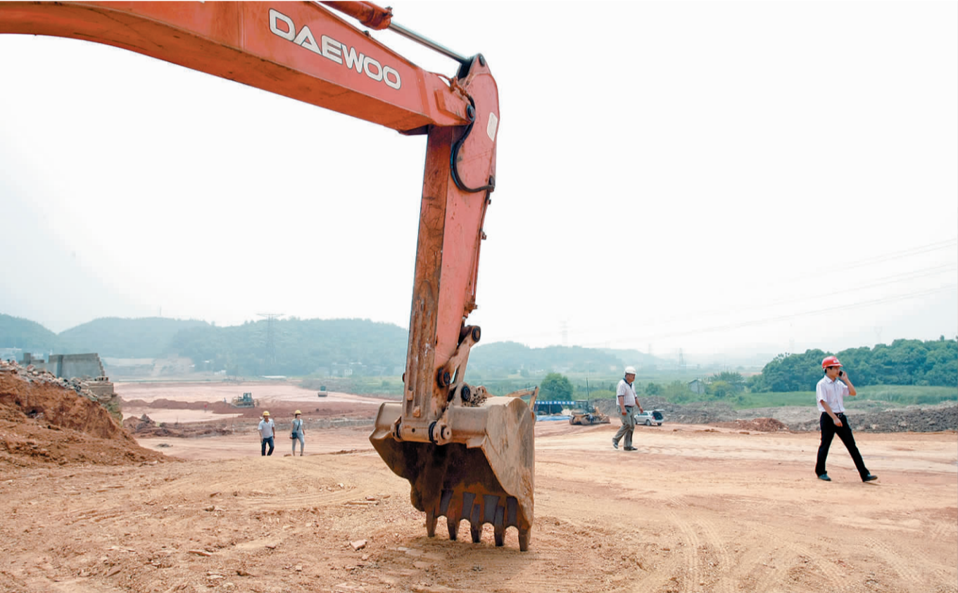
施工现场的忙碌身影。
