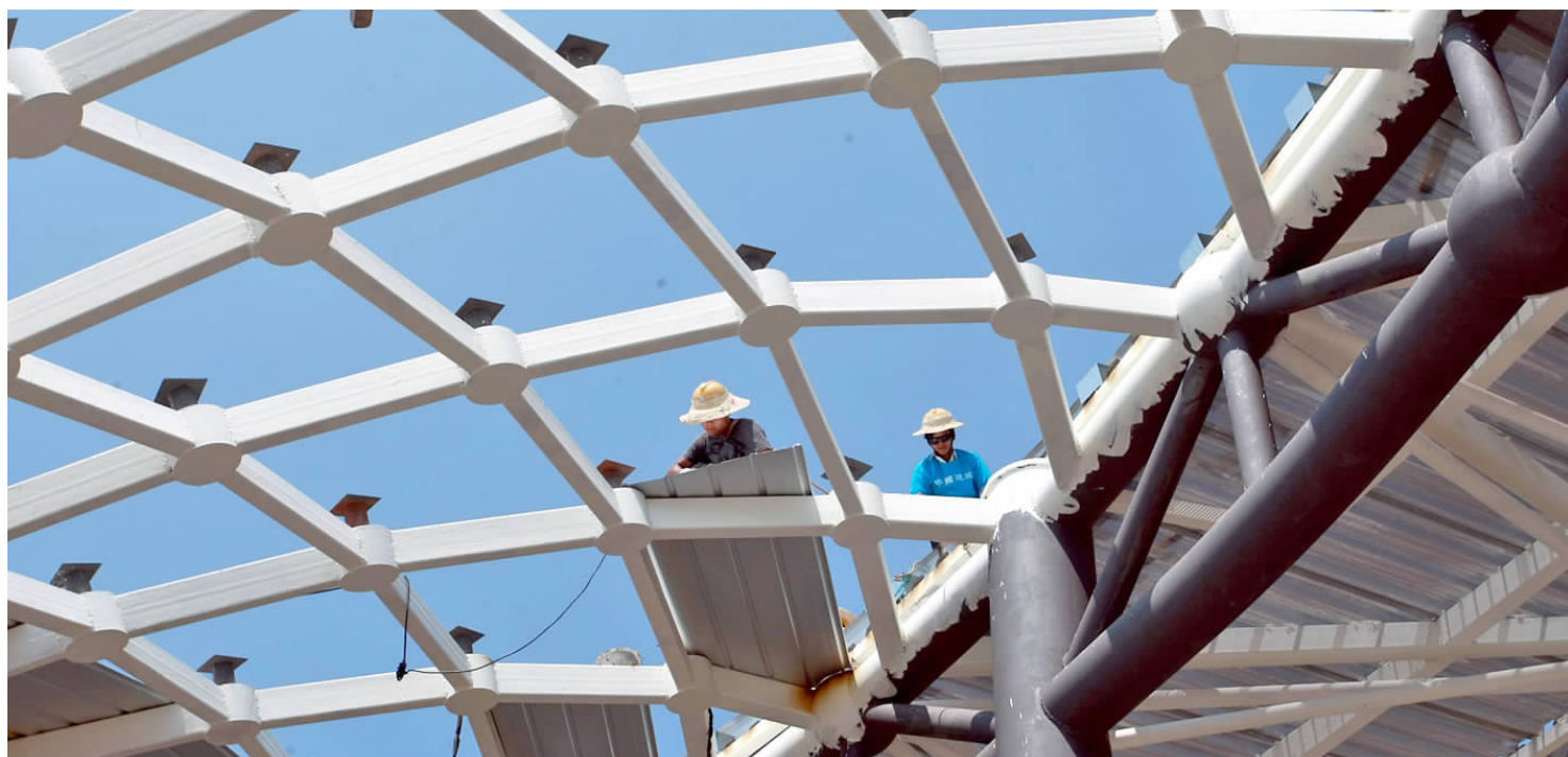
头顶烈日高空作业。
