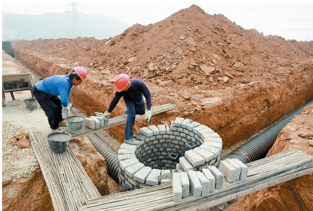
10月7日,工人们在昭华大道工地砌下水道工程。
