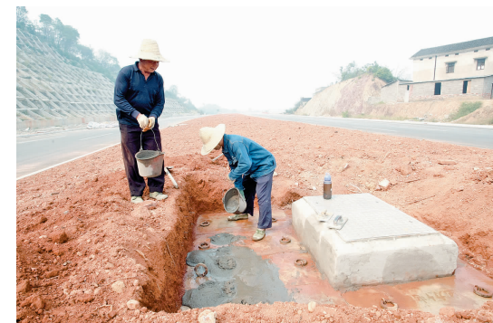
施工人员在白合大道一期对配套项目进行施工。
