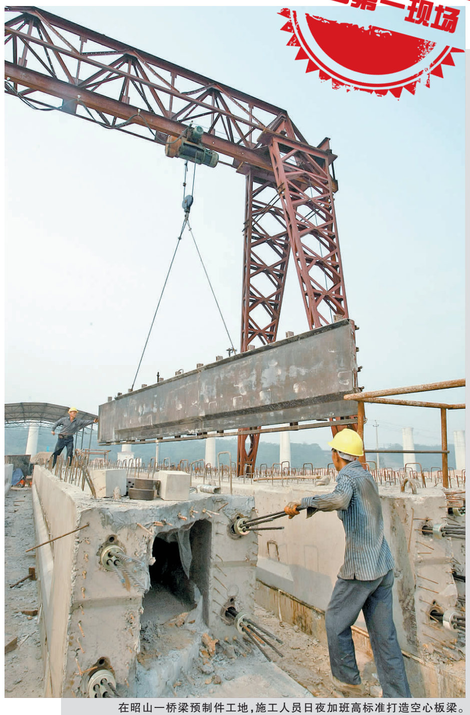
在昭山一桥梁预制件工地,施工人员日夜加班高标准打造空心板梁。
