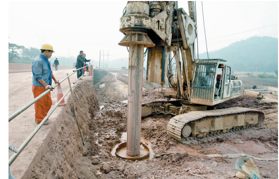
在昭山大道施工场地,技术人员正在用旋桩机打桩。
