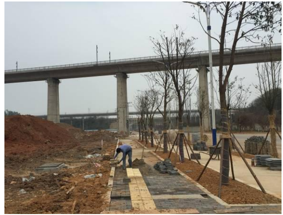
项目安置区东侧长株潭城际高铁湘潭支线
