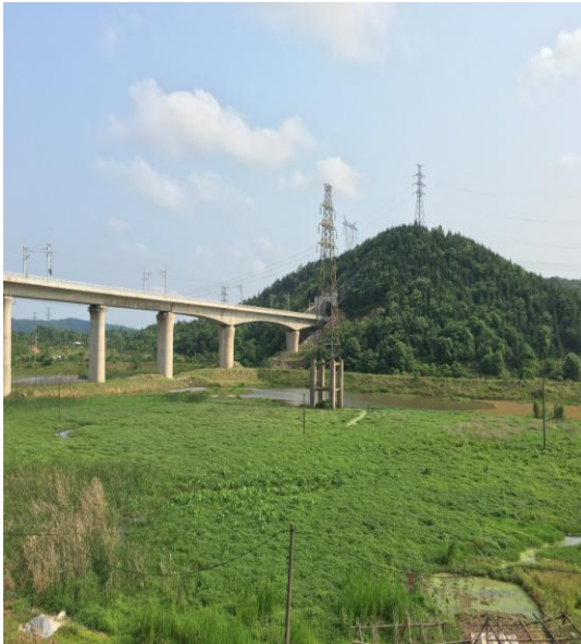
下穿城际铁路处
